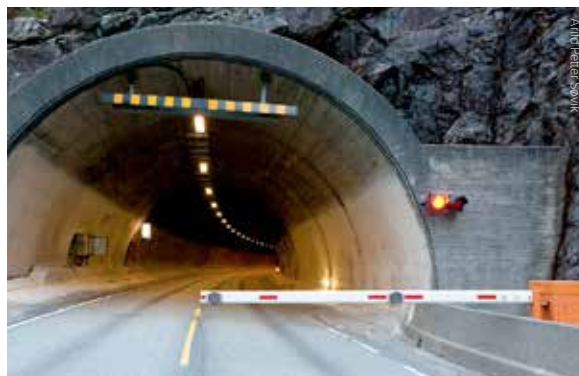
Туннель закрыт шлагбаумом
